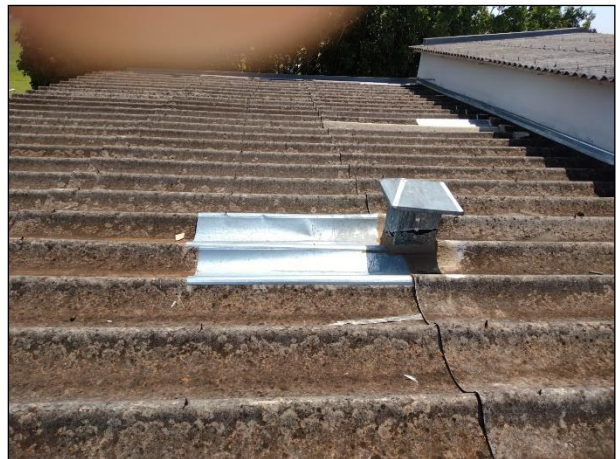
Figura 10 – Cobertura a ser substituída e chaminé a ser prolongada.
